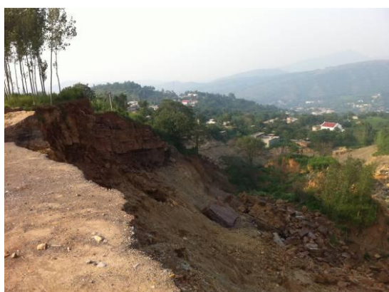
照片 3-1 采坑 2 内岩体崩塌点
