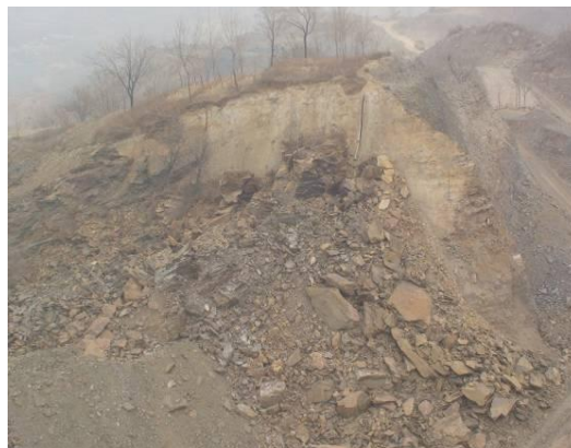
照片 3-2 采坑 2 内滑坡处
