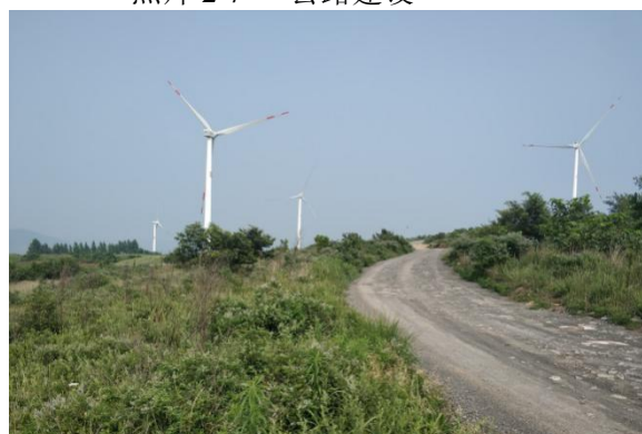
照片 2-9 电力设施建设
