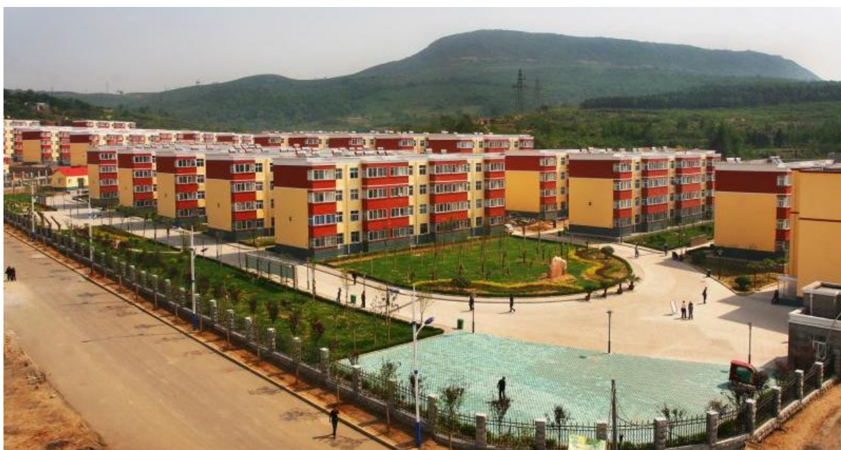
照片 2-13 一矿塌陷区住房改造工程
