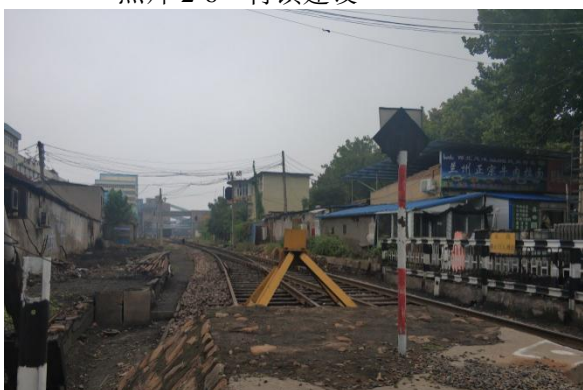
照片 2-8 运煤铁路
