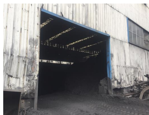
照片 1-6 矿井储煤场
