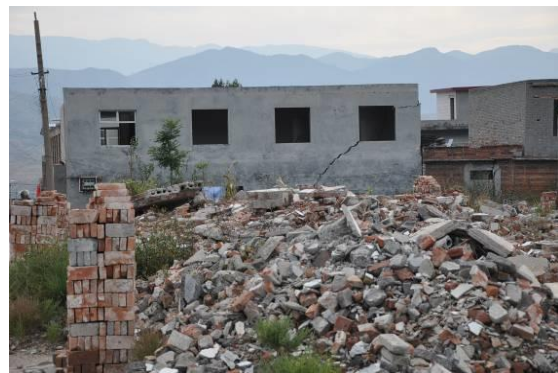
照片 3-3 损毁房屋 2
