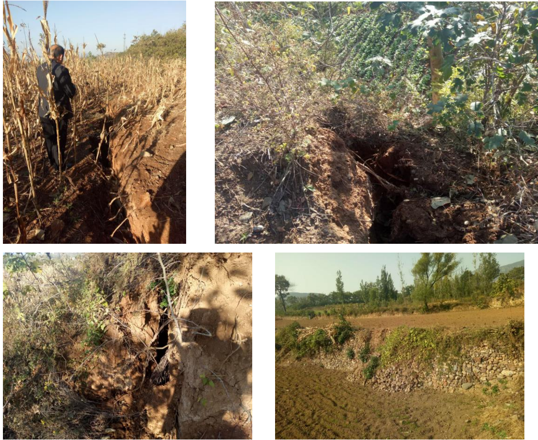
照片 3-1 地裂缝破坏情况
