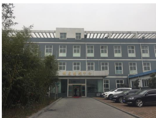
照片 1-5 矿井办公楼
