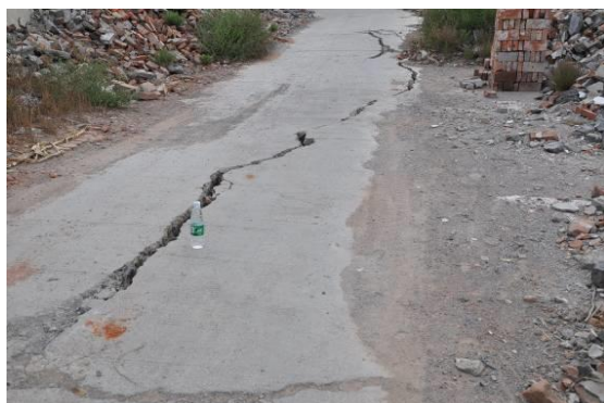
照片 3-4 地裂缝
