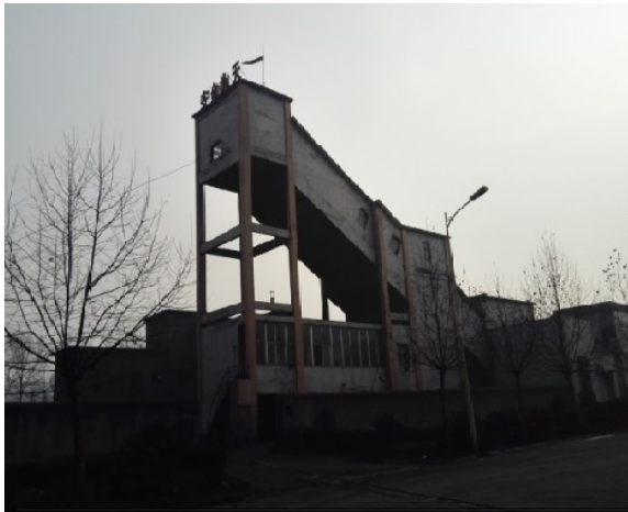
照片 1-3-3 主斜井井口
