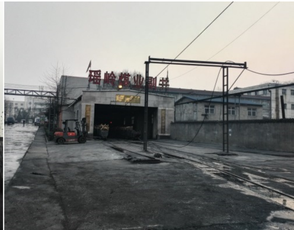
照片 1-3-4 副斜井井口
