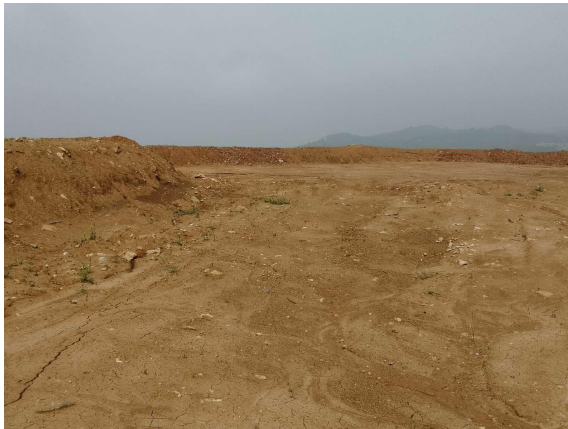
照片 1-1 III号排土场顶部
