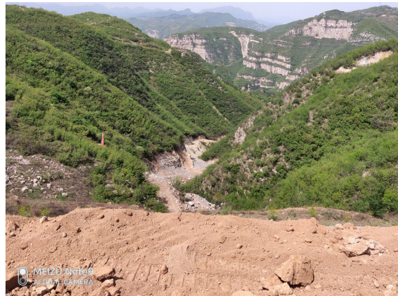
照片 1-2 III号排土场边坡
